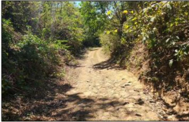
ACCESO POR CALLE DE TIERRA, EN STADO REGULAR DE CONSERVACION
