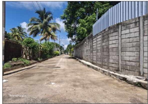
CALLE DE ACCESO
