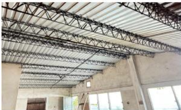
ESTRUCTURA DE TECHO
