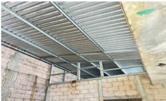
ESTRUCTURA DE TECHO
