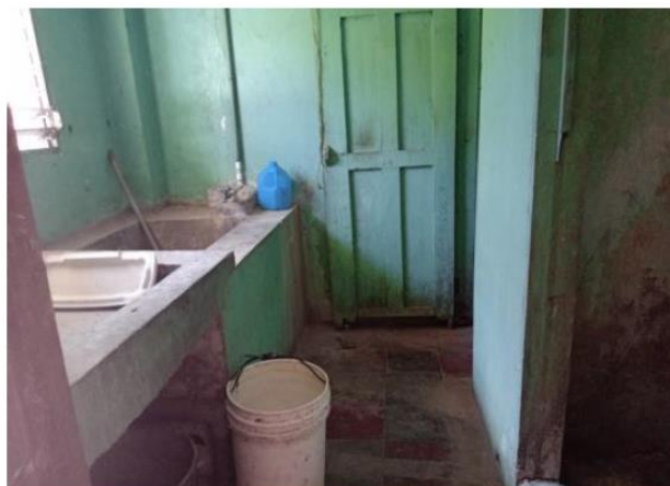
SS EN CONSTRUCCION 2
