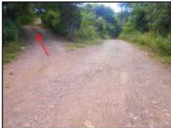
ENTRADA A CALLE VECINAL
