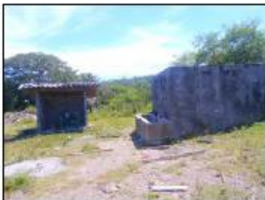
POZO Y TANQUE
