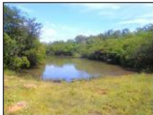
RESERVORIO DE AGUA
