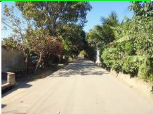
AVANCE DE OBRAS
